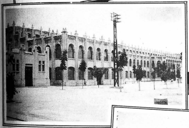
El bello edificio de las hilanderías de Maracay.
