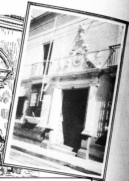
Fachada de "El Nuevo Diario", vieja mansión colonial construida en 1736.
